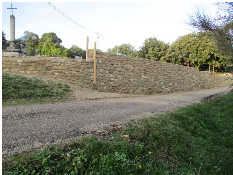
Le mur en construction
